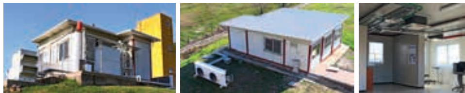
Figura 2 – Viste esterne e interne del locale container
